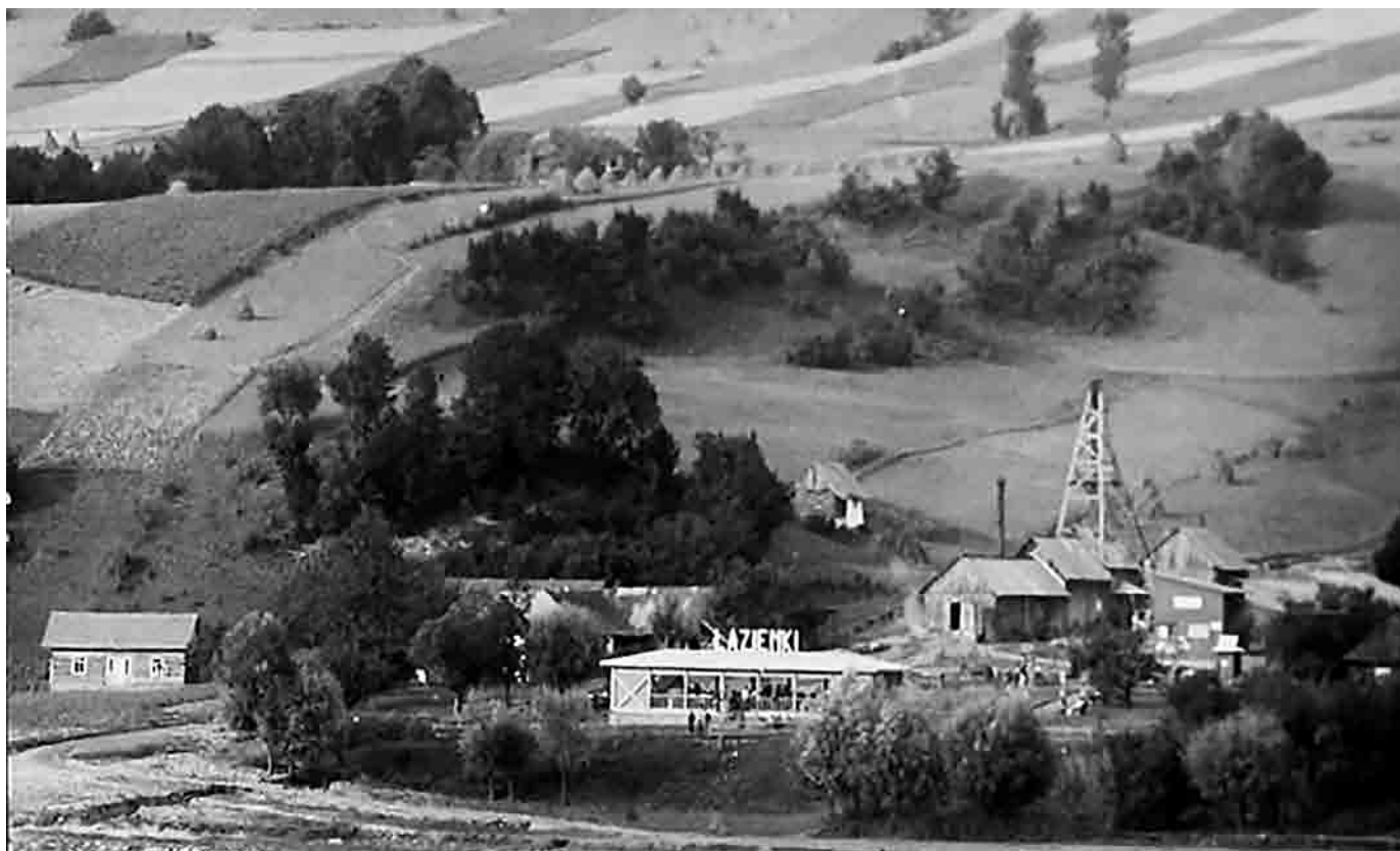
Budowa szybu wody mineralnej i Łazienek na Zawodziu
