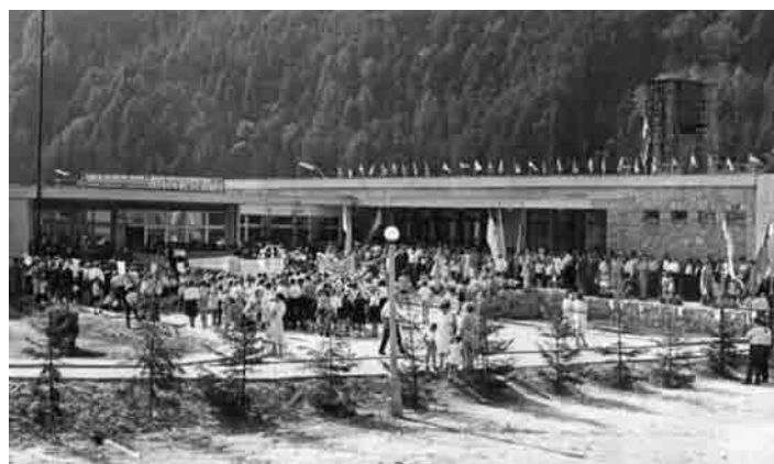
Młodzież przed nowym budynkiem szkoły
