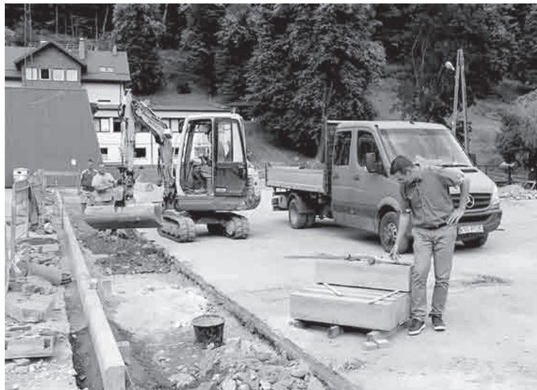
Budowa boiska w Kosarzyskach
