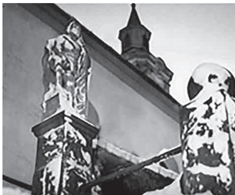
Nieistniejąca figura św. Floriana przy dawnych schodach do kościoła
