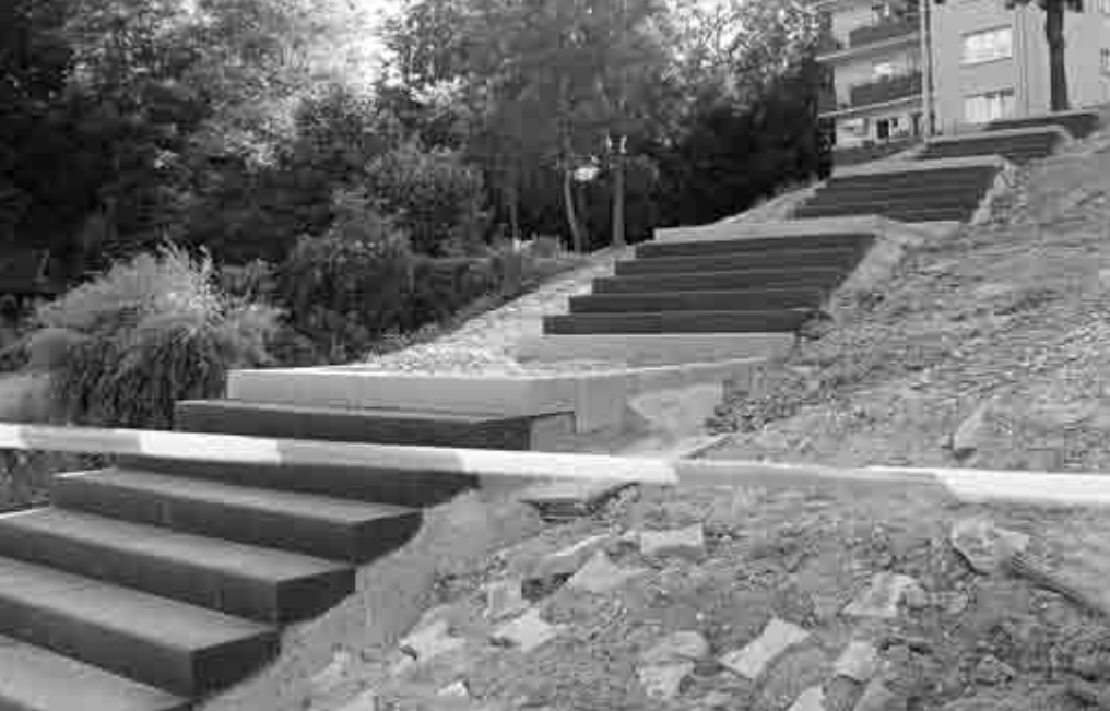
Budowa nowych schodów na Osiedlu „Uwrocie”
