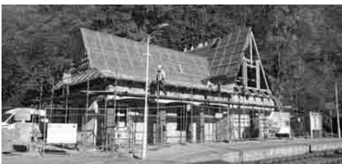
Remont dworca PKP w Wierchomli Wielkiej
